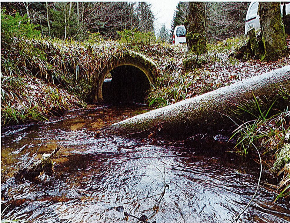
Figure 2: Vue de l'entrée de la buse depuis l'amont de l'ouvrage
