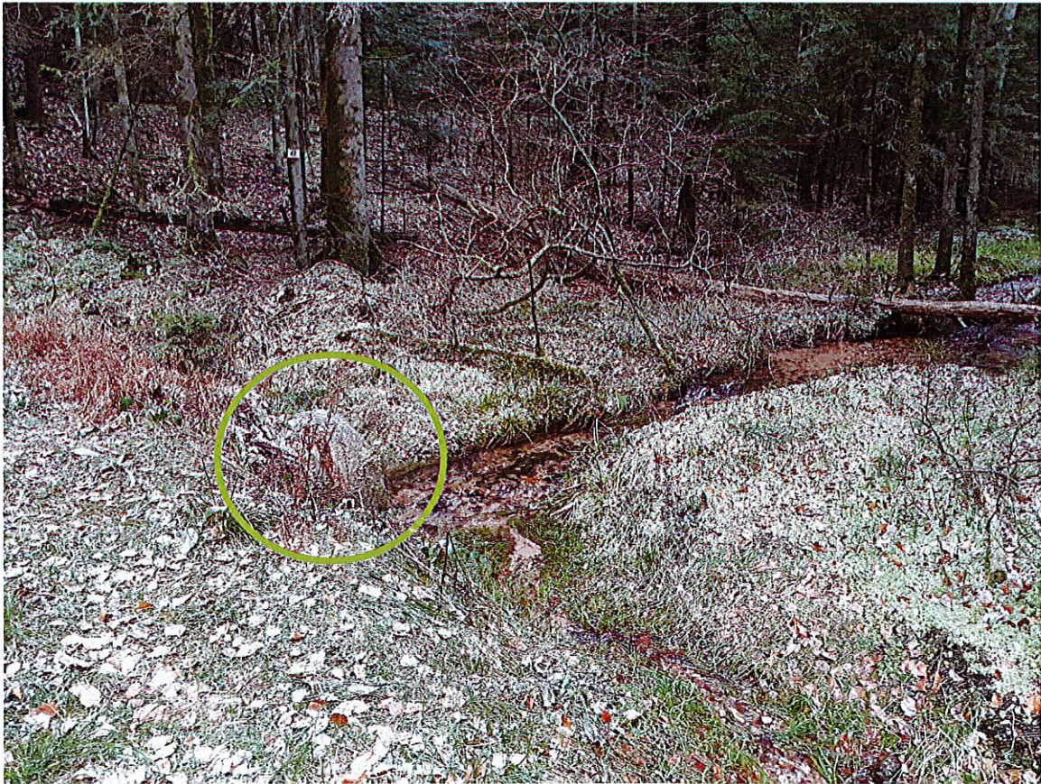
Figure 10: Vue de l'entrée de la buse (en vert) vers l'amont du cours d'eau depuis la piste
