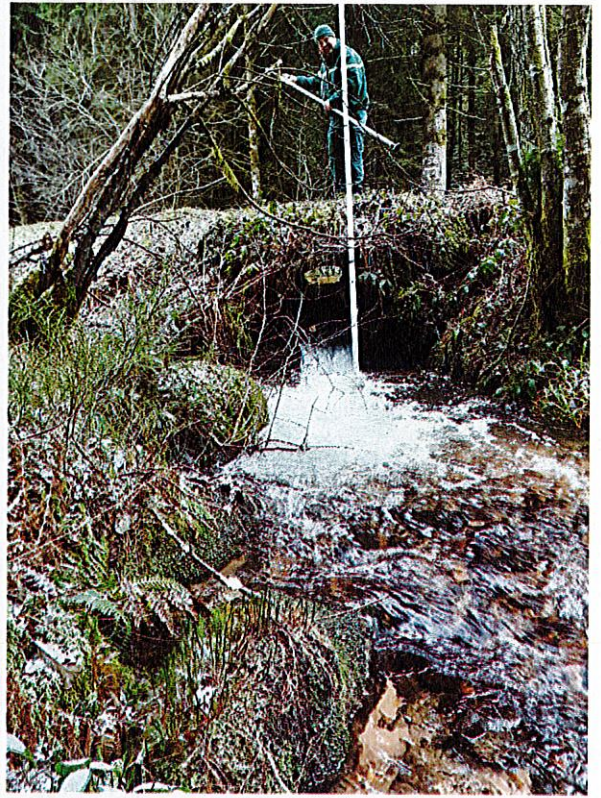
Figure 6: Sortie de la buse, vue depuis l'aval vers l'amont
