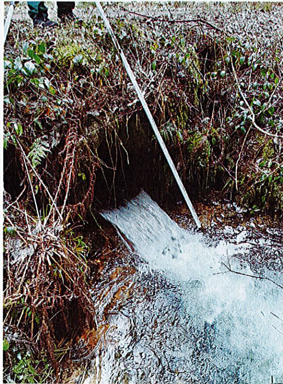
Figure 7: Sortie de la buse
