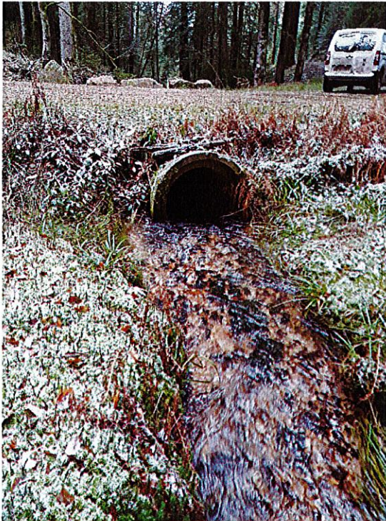
Figure 8: Vue de l'entrée de la buse depuis l'amont de l'ouvrage
