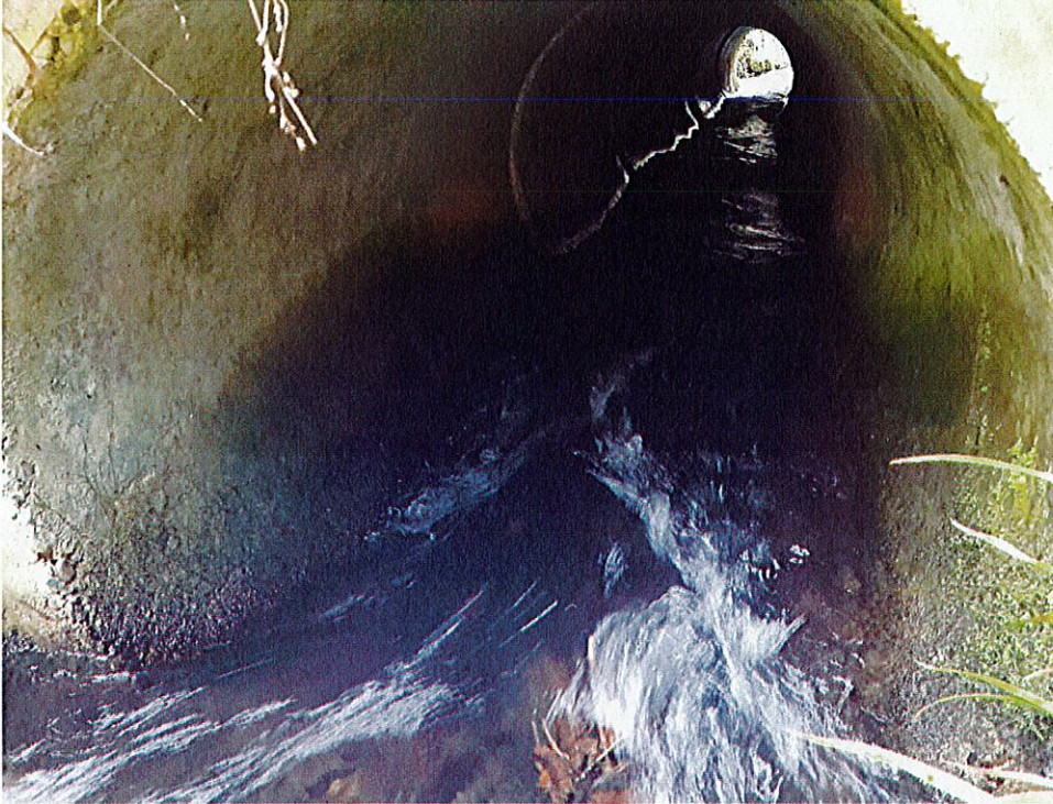
Figure 1: Vue de l'entrée de la buse depuis l'amont de l'ouvrage
